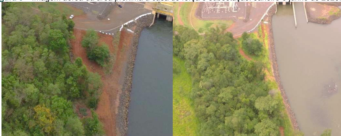
Figura 6 – Imagem aérea da área próxima à casa de força e subestação. Janeiro e junho de 2020.
