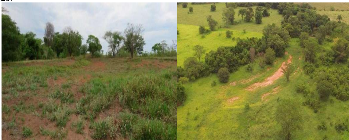
Figura 8 - Imagem aérea da área à jusante do barramento (área ampliada do canteiro). Janeiro de 2020.
