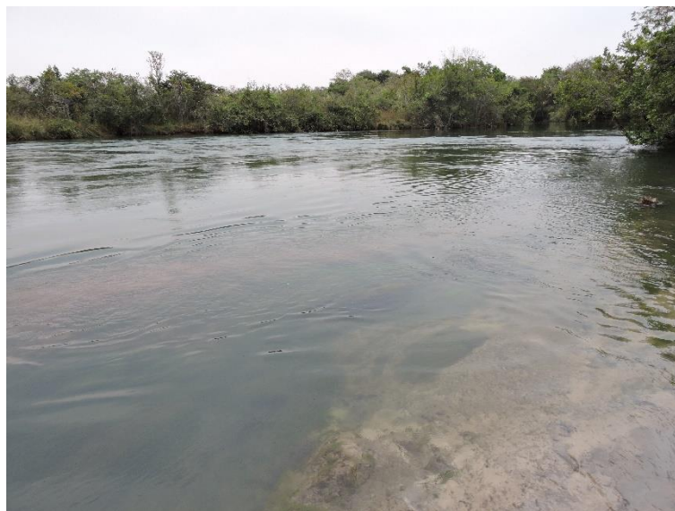
Figura 3. Trecho a jusante do barramento no monitoramento da ictiofauna na PCH Verde 4, Água Clara – MS. Agosto de 2020.
