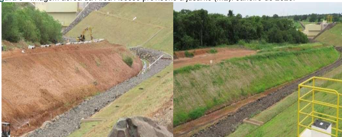
Figura 9 - Imagem aérea da Área Acesso provisório à jusante (ME). Janeiro de 2020.
