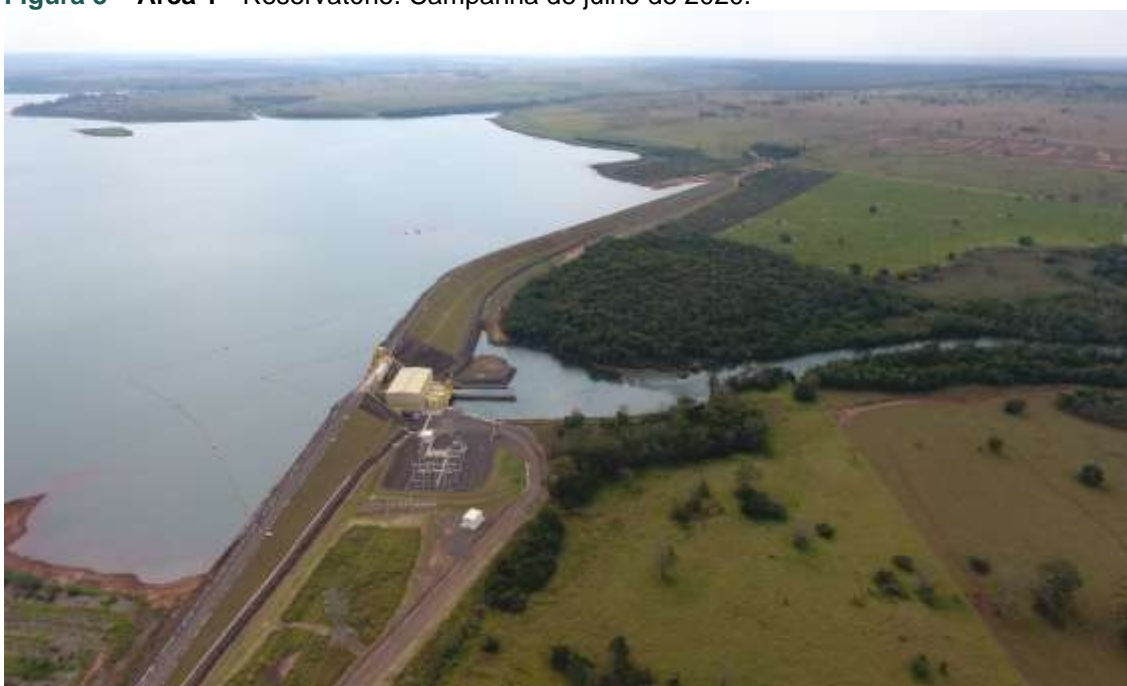
Figura 3 – Área 1 - Reservatório. Campanha de julho de 2020.
